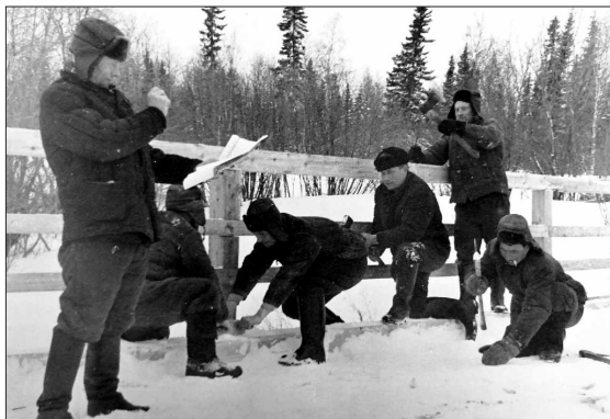
Фото 4. Строительство моста через Высокую веретию
