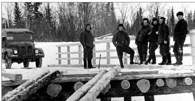
Фото 5. Строительство моста через Высокую веретию (колхоз «Труженик»)
