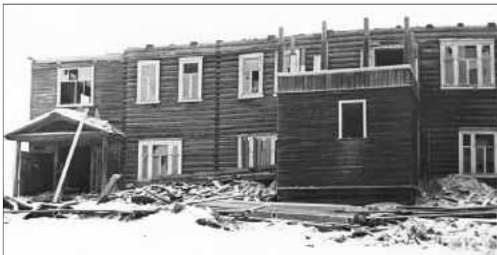
Фото 5. Разборка здания для переноса (1978 г.)
