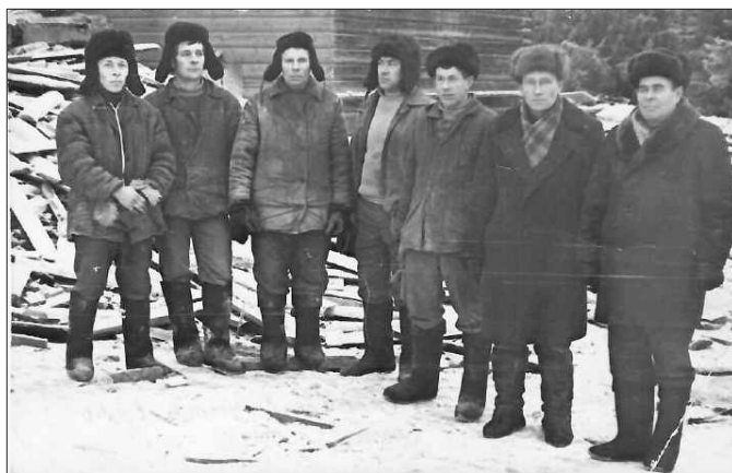
Фото 6. Строительная бригада РСУ (В.Г. Мальцев, А.И. Дуркин, Д.В. Поздеев, И.П. Чупров, Г.М. Поздеев, Г.Т. Хозяинов)
