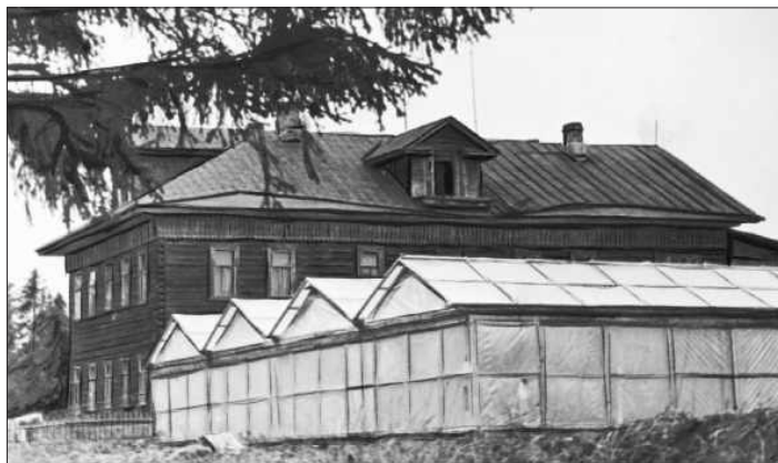
Фото 2. Здание опытной станции в пос. Журавский
