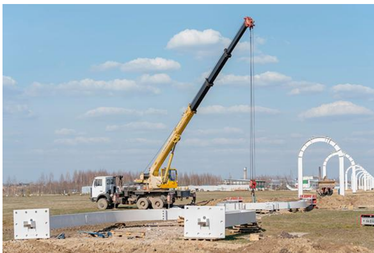
Рисунок 1 - Возведение опор новой трассы в ЭкоТехноПарке SkyWay
